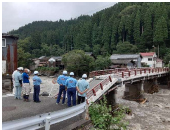
現地調査状況
